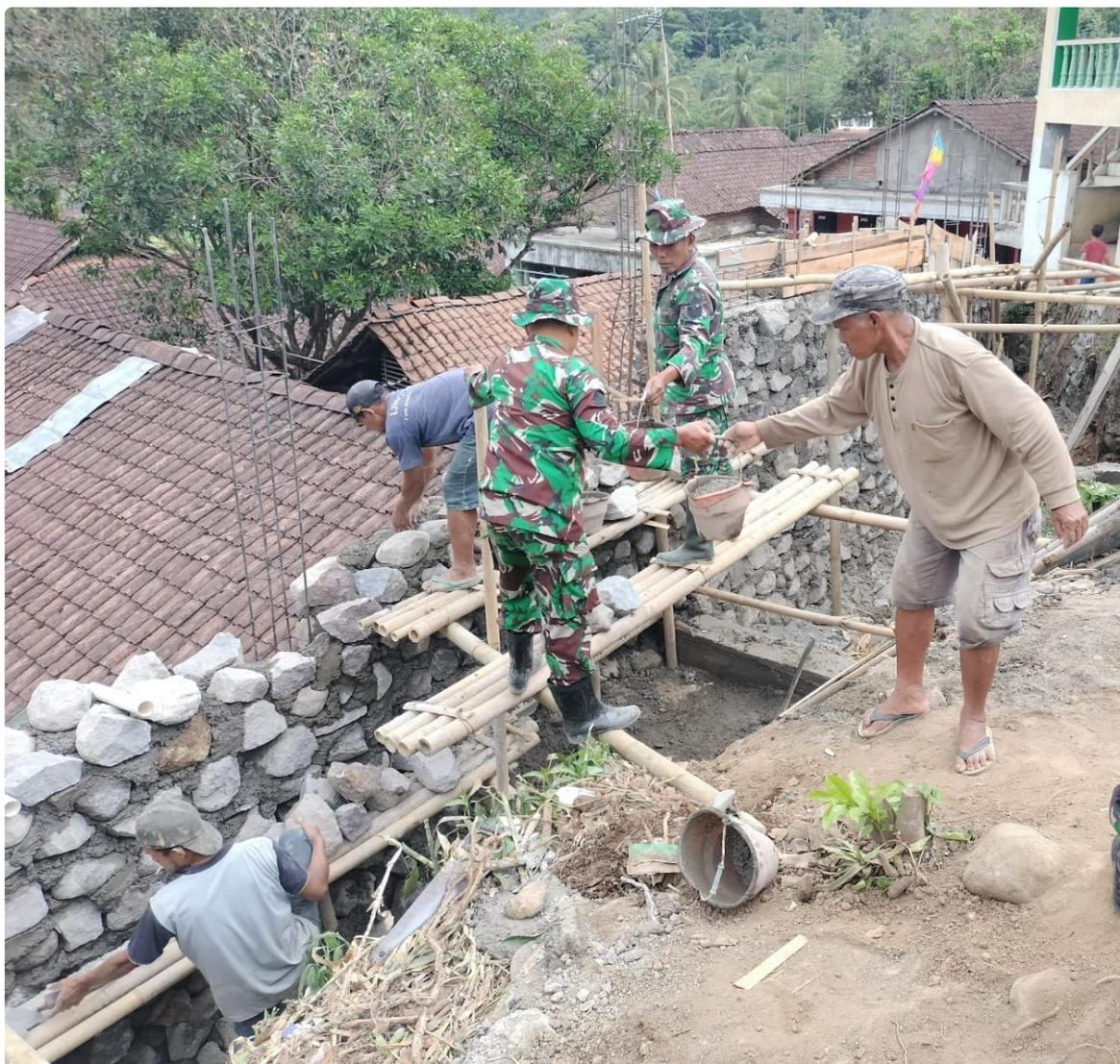
Hal ini terlihat dari pengerjaan secara fisik betonisasi sarana jalan sepanjang 226 meter, lebar 2 meter, dengan tebal 12 cm serta mengerjakan talud senderan sepanjang 15 meter dan tinggi 6 meter yang terletak di depan masjid Baiturrahman Dusun Petung Lumut Desa Ngepanrejo, Sabtu ( 15/07).
